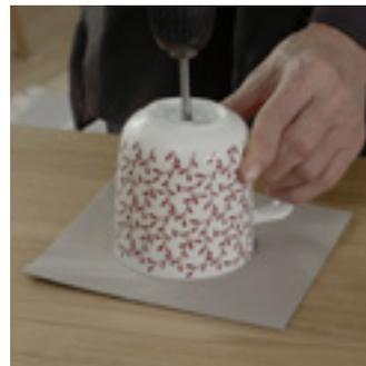
**3** Setzen Sie den Bohrer an der markierten Stelle an und bohren Sie mit dem 8 mm-Bohrer langsam und mit wenig Druck ein Loch, das ein wenig größer ist als der Durchmesser des Kabels. Füllen Sie beim Bohren immer wieder Wasser nach, damit der Bohrer nicht zu heiß wird.
